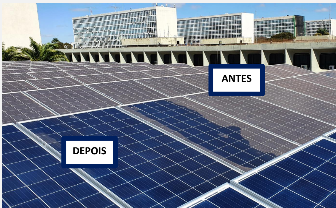
Placas com poeira depositada e Placas limpas
